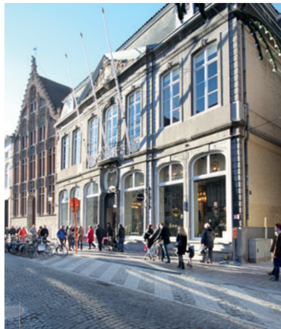
Bruges, Steenstraat - 941 m 2
