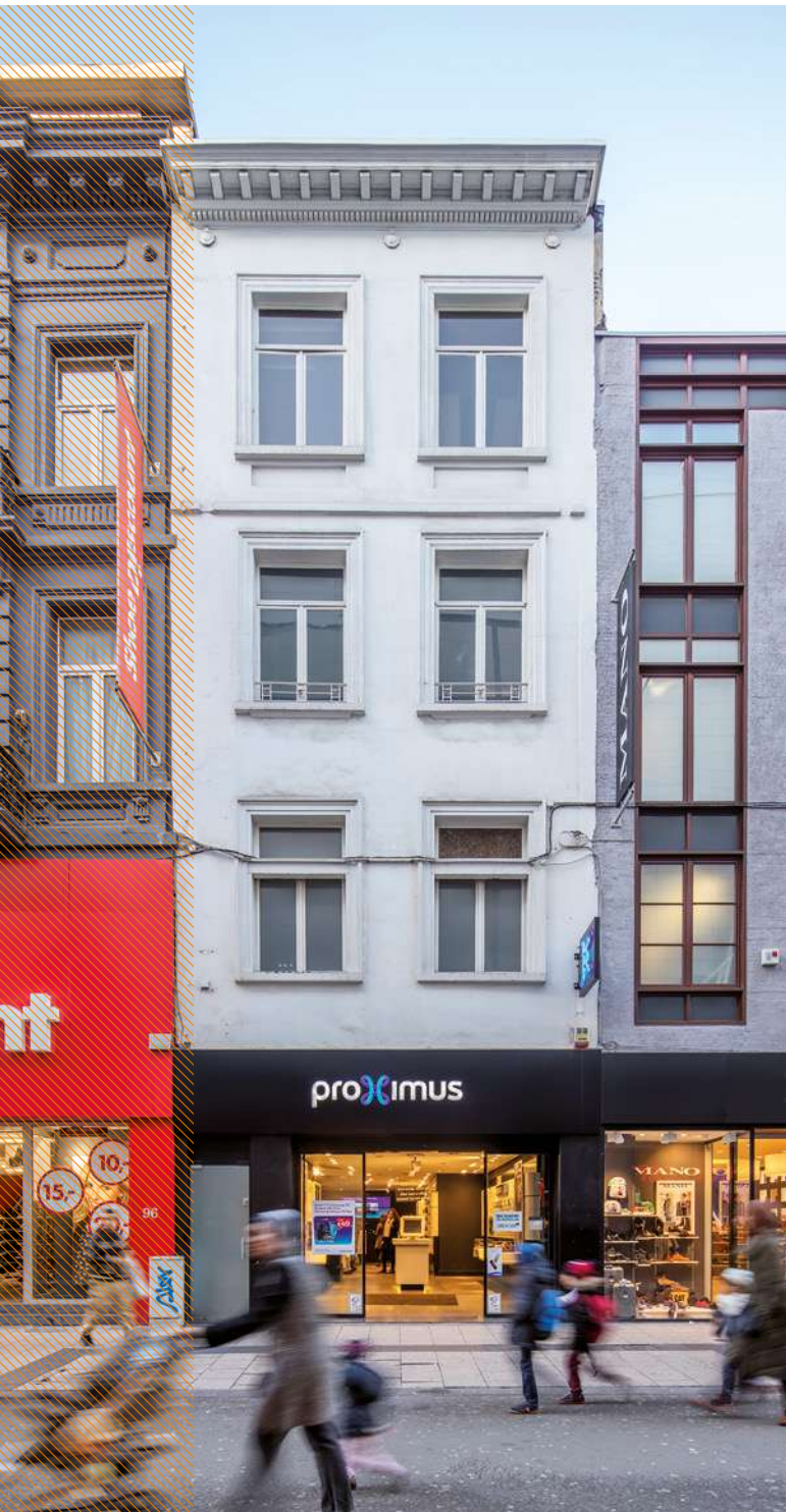
Brussel - Nieuwstraat - Proximus
